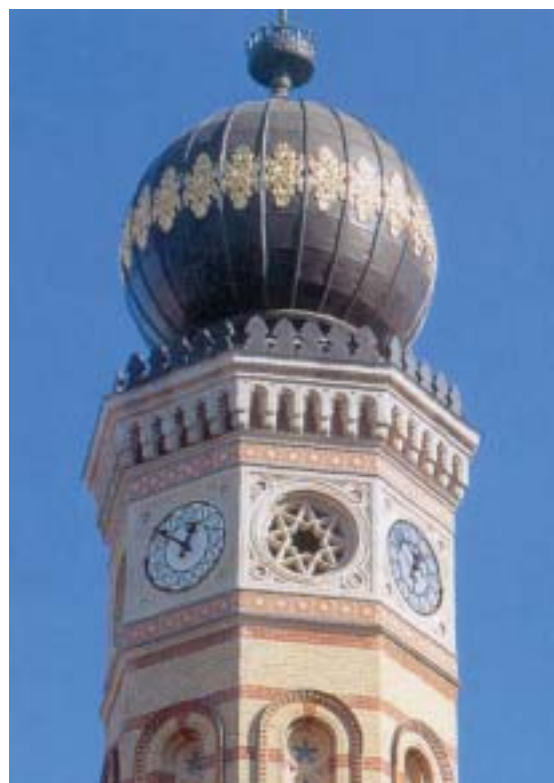
A budapesti zsinagóga épülete
